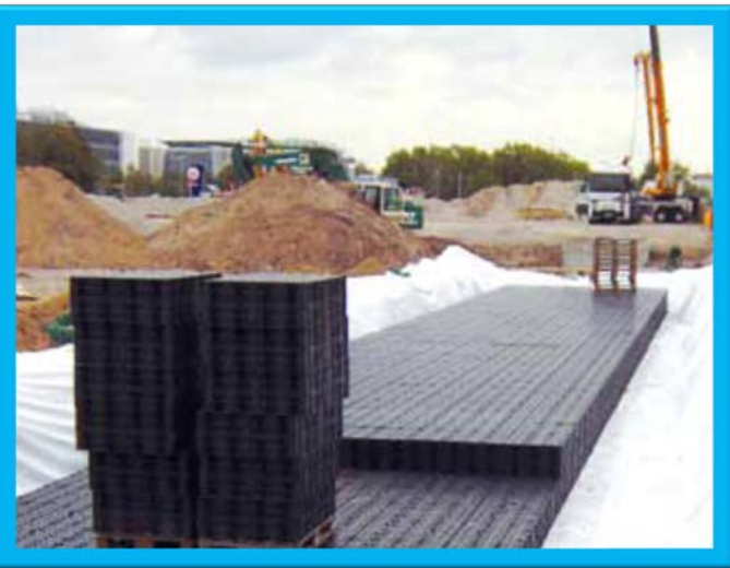
DRAINFIX BLOC инфильтрация дождевой воды ООО "Хауратон ООО"
